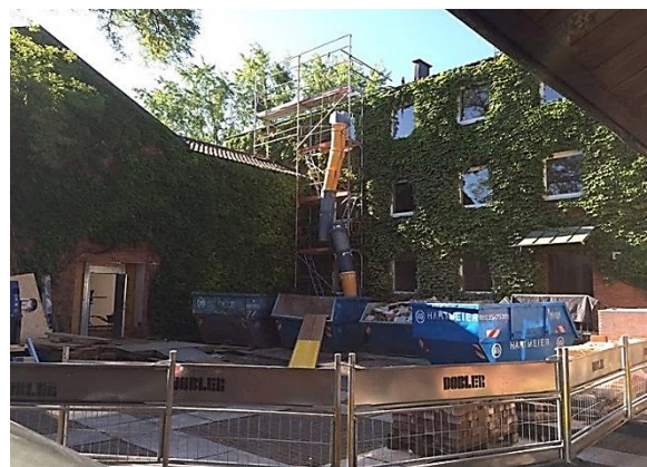
Umbauphase im Studienseminar, Eingangsbereich
