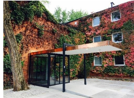
Eingang nach Sanierung
