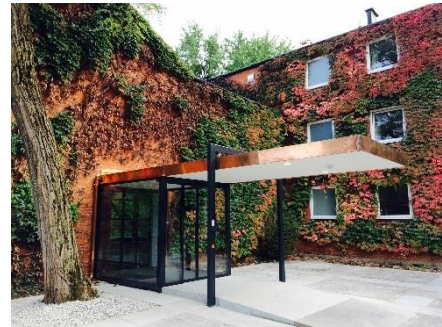
Eingang nach Sanierung
