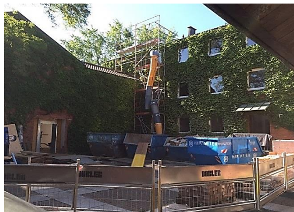
Umbauphase im Studienseminar, Eingangsbereich
